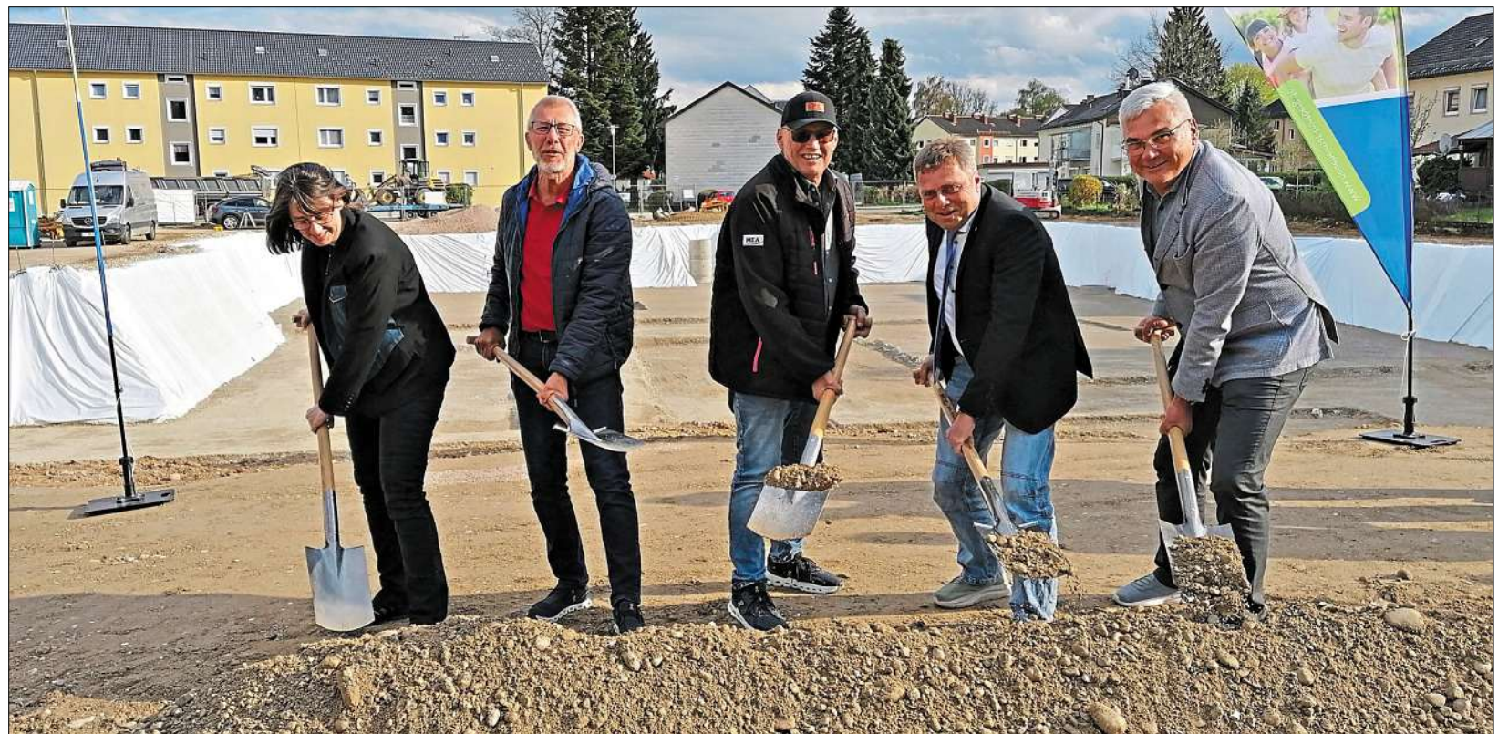
Der offizielle Spatenstich zum Bau von 40 neuen Wohnungen an der Gerhart-Hauptmann-Straße in Traunreut durch die Neue Heimat Trostberg ist gesetzt. Unser Foto zeigt (von links) die Architektin Ute Weiler Heyers, Bauleiter Hans Drexler, Klaus Aigner von der gleichnamigen Baufirma, Geschäftsführer Gerhard Hofer von der Neuen Heimat und Traunreuts Zweiten Bürgermeister Reinhold Schroll. – Foto: Rasch
